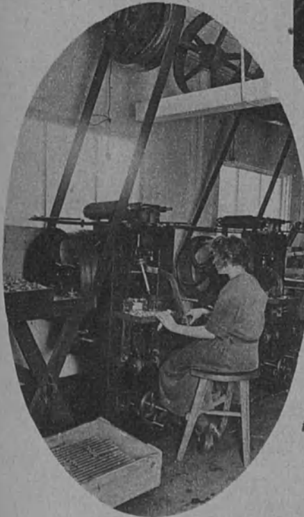
Valssatut lyijy- tai linaharkot saksataan ja senjälkeen lyödään niistä tuubin läpimitää vastaavat lanlit. Kuvassa oikealla kuivauskaappi värinpainetuille tuubeille. — Oikealla: Muutamia Oy. Hermetic Ab:n valmistamia tuubeja.
