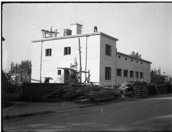
Kuva 115: Sauna rakennusvaiheessa. Valok. Jalmari Lankinen 1934, Finna.fi
