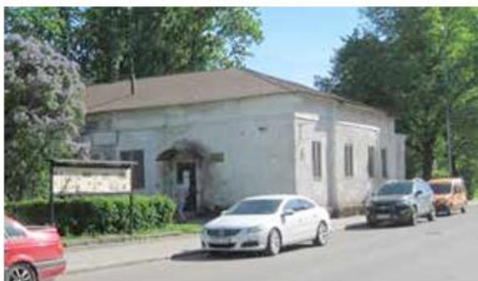
Den gamla bastubyggnaden Vasagatan 17.
