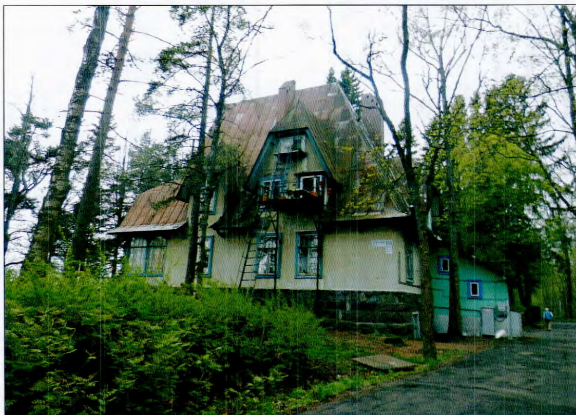
1. Общий вид с северо-востока.
