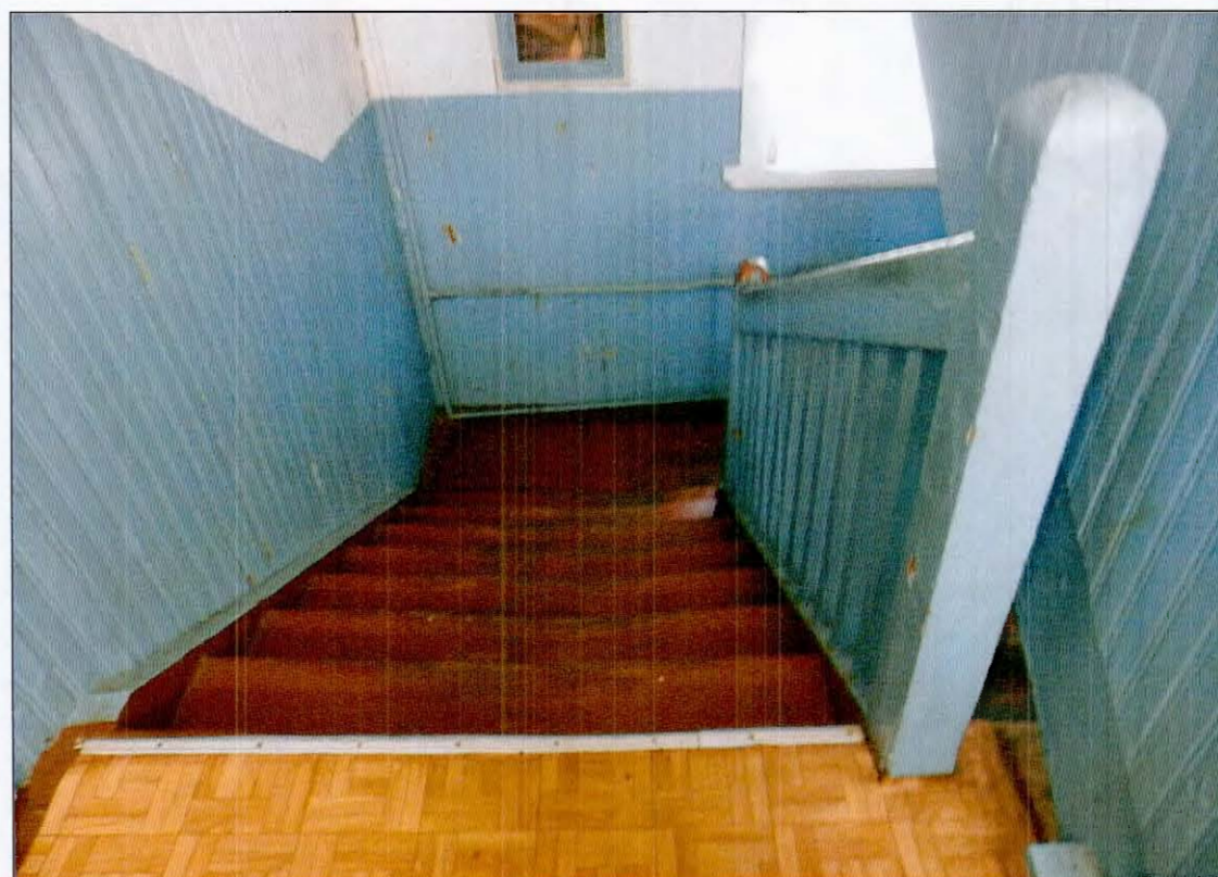
7. Интерьер. Фрагмент лестничного пространства.
