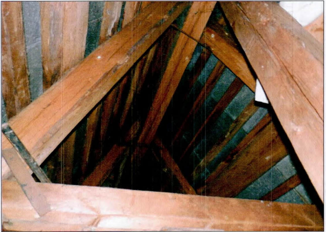
8. Стропильная система. Фрагмент.
