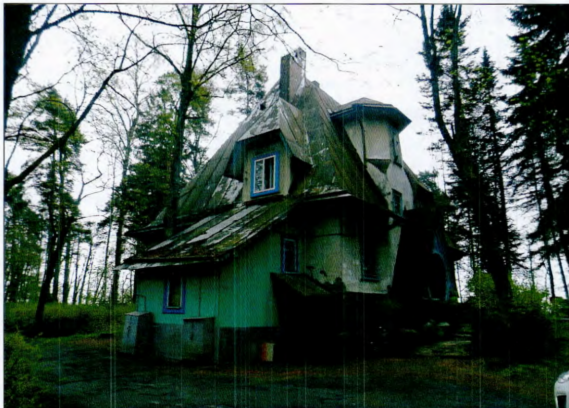
2. Общий вид с северо-запада.
