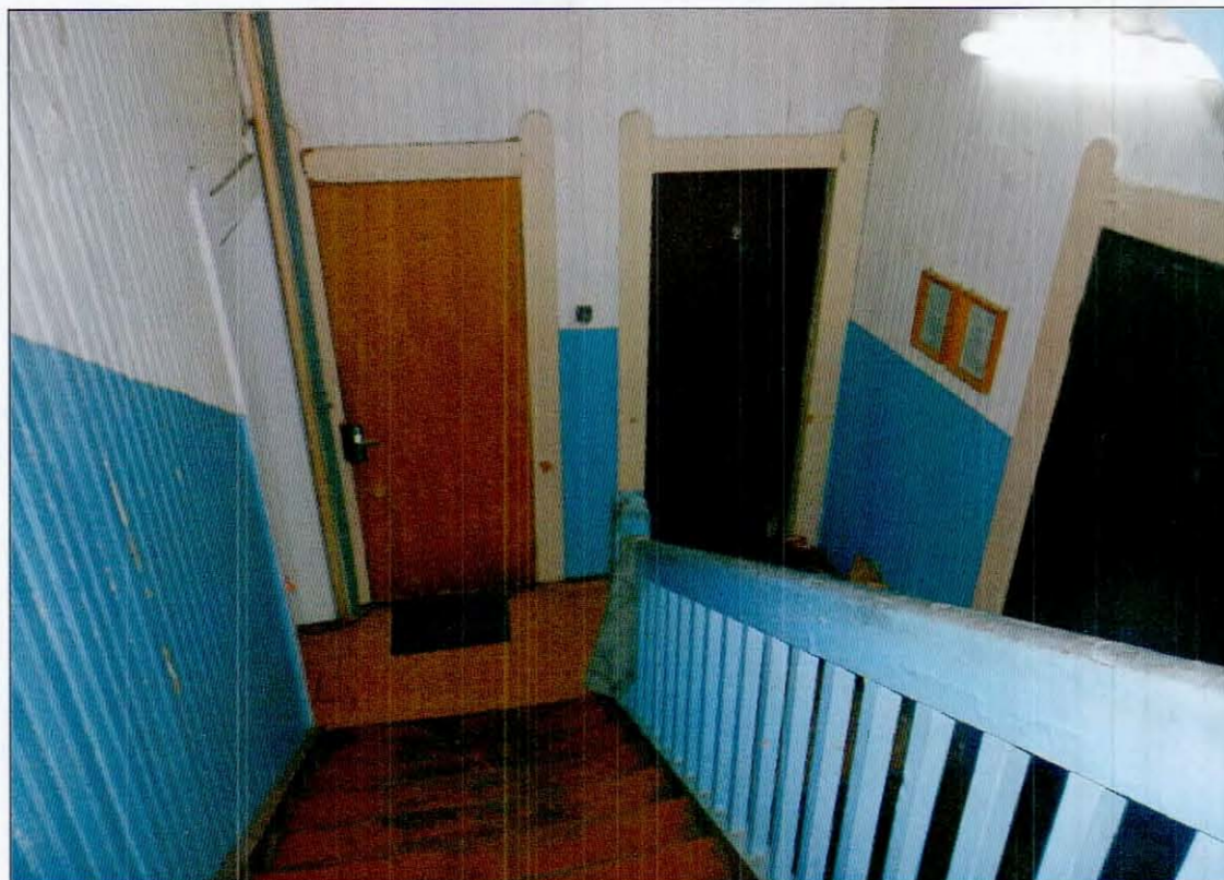
6. Интерьер. Фрагмент лестничного пространства.
