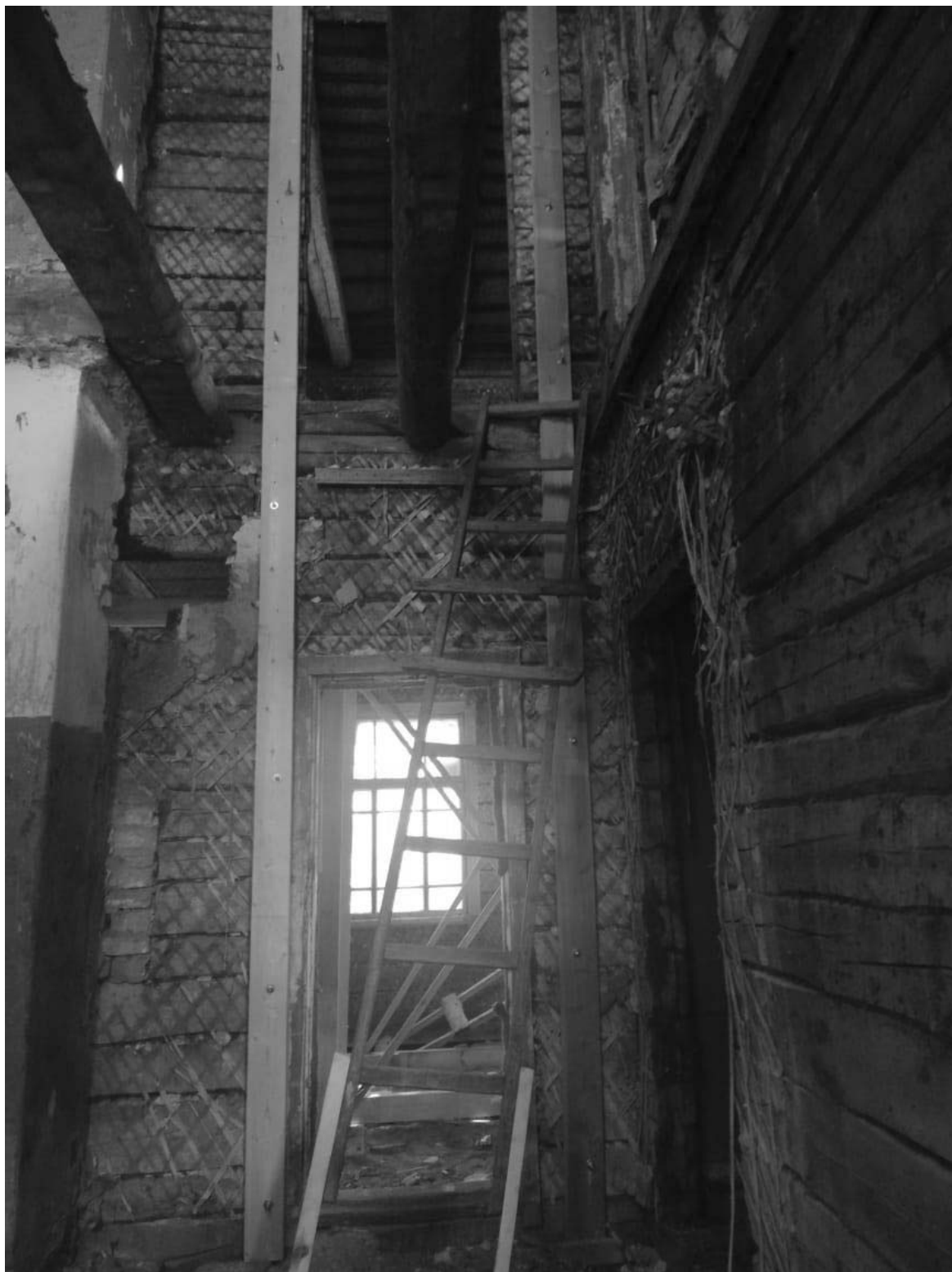
Фото № 13. Фрагмент помещения № 9 (по техпаспорту).
