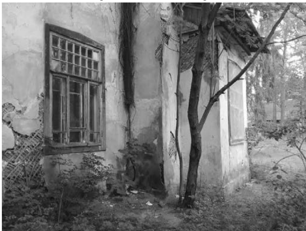
Фото № 4. Фрагмент восточного фасада здания.
