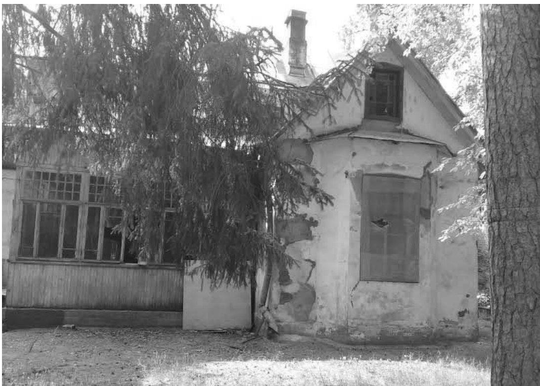
Фото № 11. Фрагмент северного фасада с ризалитом.
