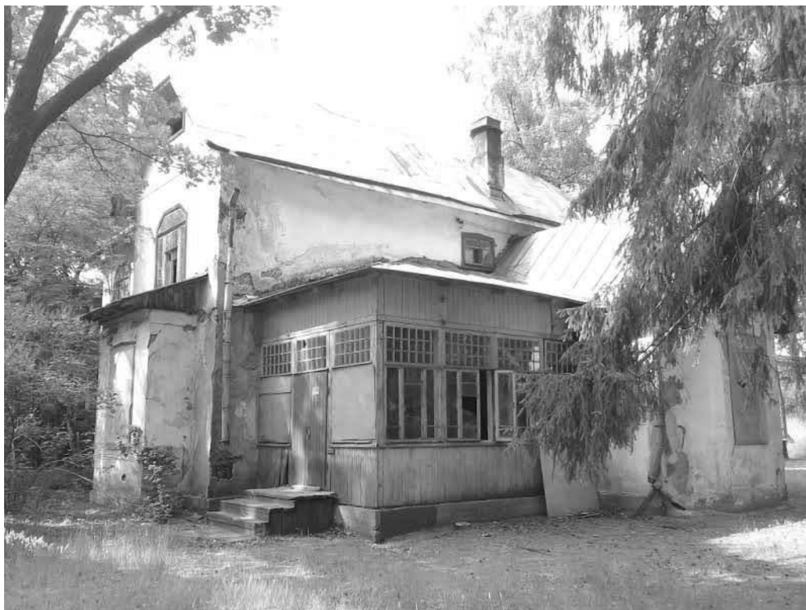
Фото № 1. Общий вид здания с северо-востока.
