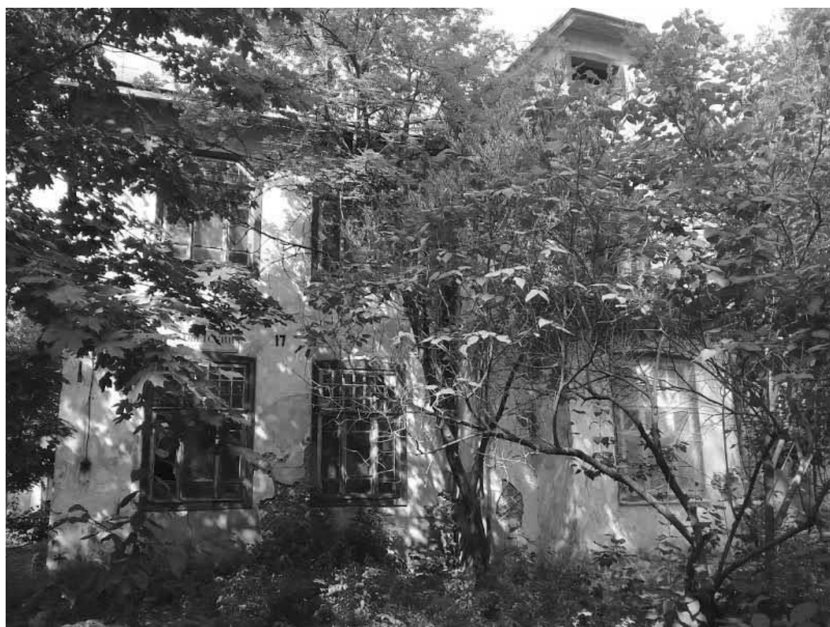
Фото № 2. Общий вид восточного фасада здания.
