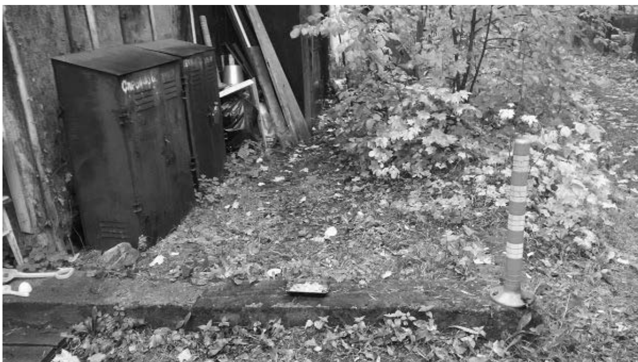
Ил.18. Дача Р. Павлова. Юго-западный угол дома. Фундамент сгоревшей части дома. Фото 2014 г.
