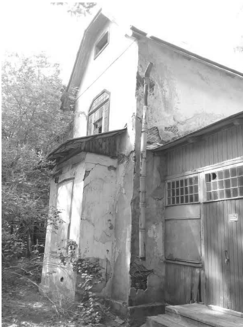
Фото № 3. Фрагмент восточного фасада здания.
