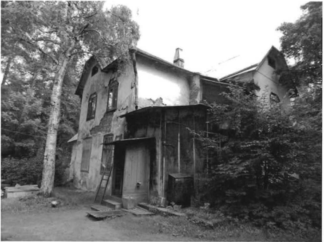
2. Западный и южный фасады
