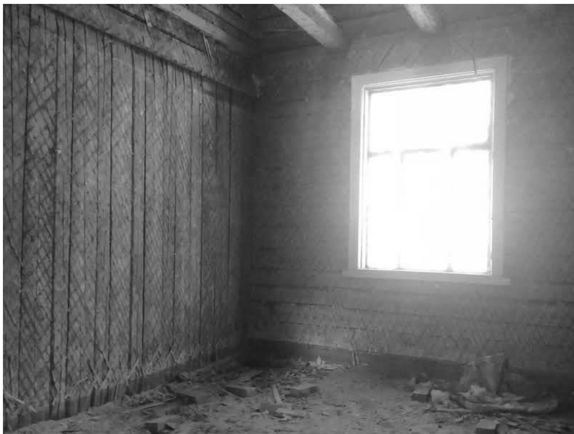
Фото № 21. Помещение № 7 (по техпаспорту).
