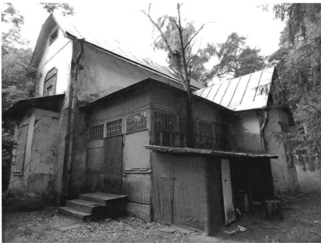
4. Восточный и северный фасады
