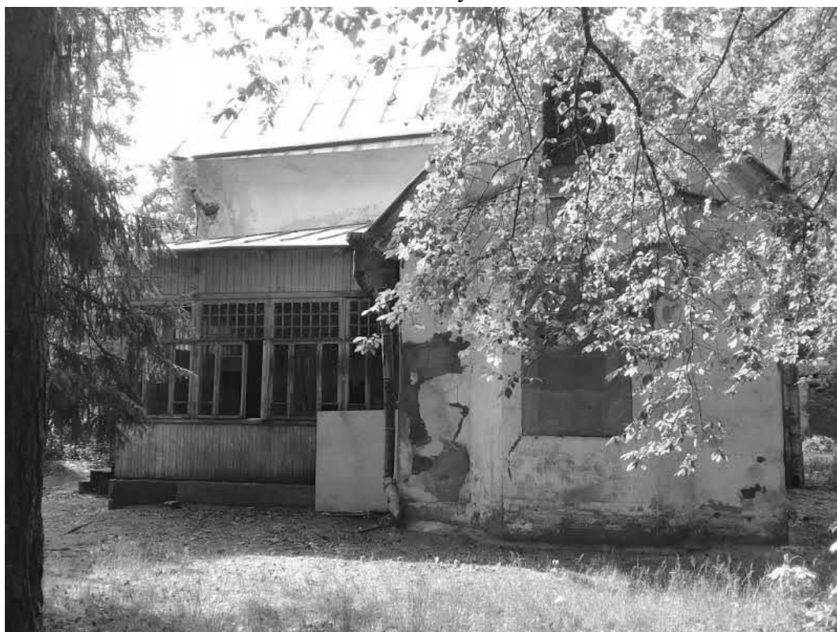
Фото № 10. Общий вид северного фасада.
