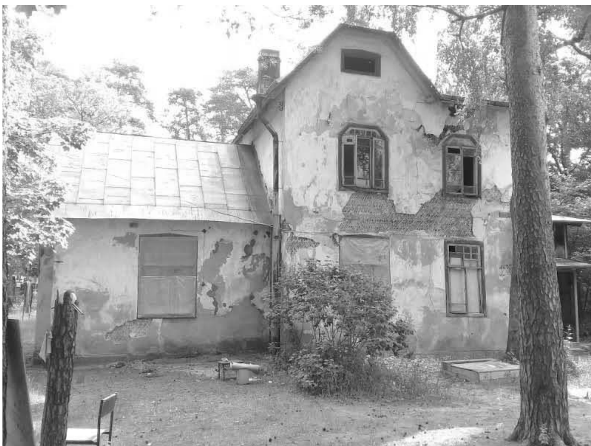
Фото № 8. Общий вид западного фасада.
