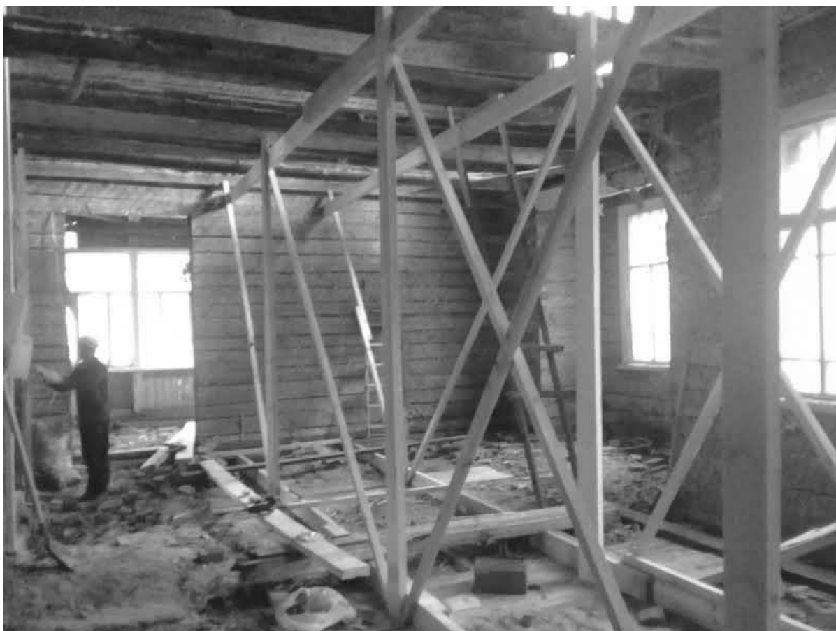
Фото № 17. Общий вид помещений № 3, 4 (по техпаспорту) с противоаварийными конструкциями.
