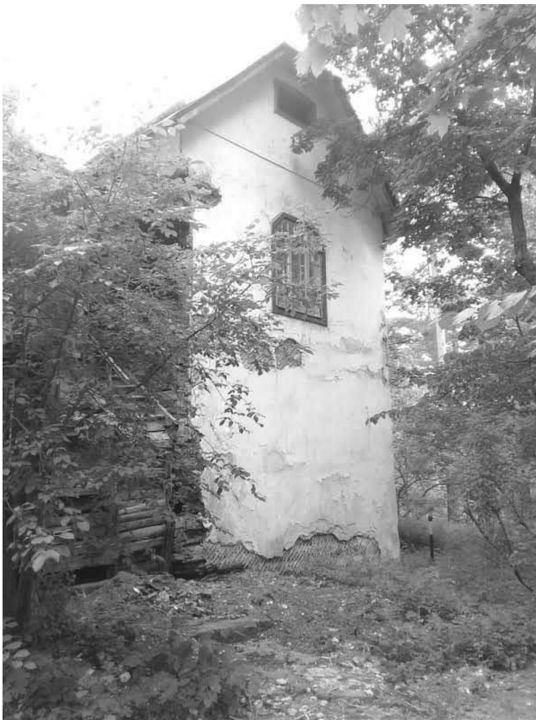
Фото № 5. Фрагмент южного фасада.
