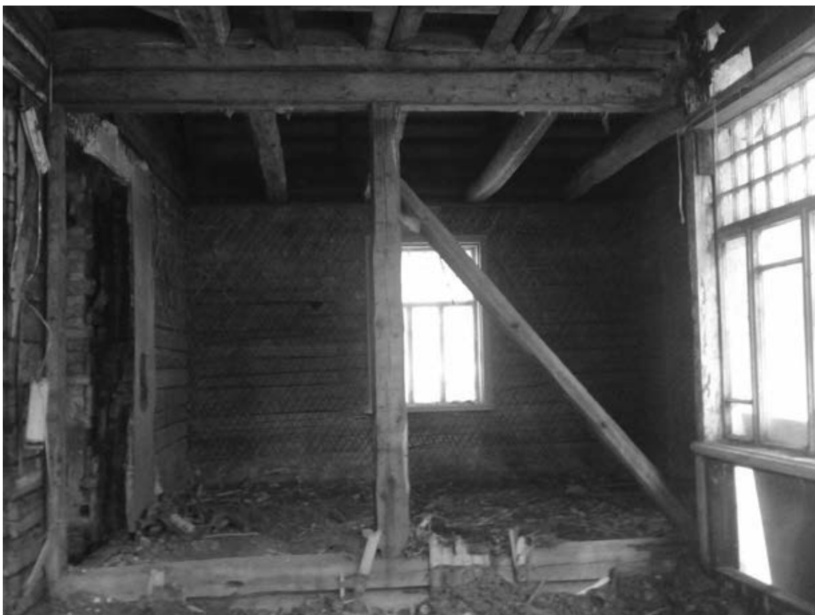
Фото № 19. Общий вид помещений веранды и помещения № 6 (по техпаспорту).
