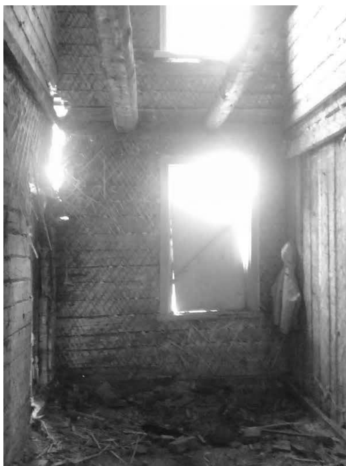
Фото № 15. Общий вид помещения № 8 (по техпаспорту) и вышерасположенного пространства с чердаком.
