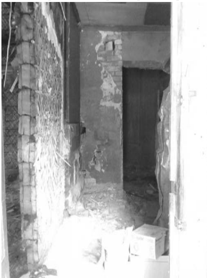
Фото № 12. Общий вид помещения № 1 (по техпаспорту), часть которого была утрачена в результате пожара.
