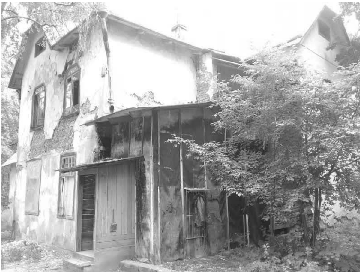
Фото № 7. Общий вид здания с юго-востока.
