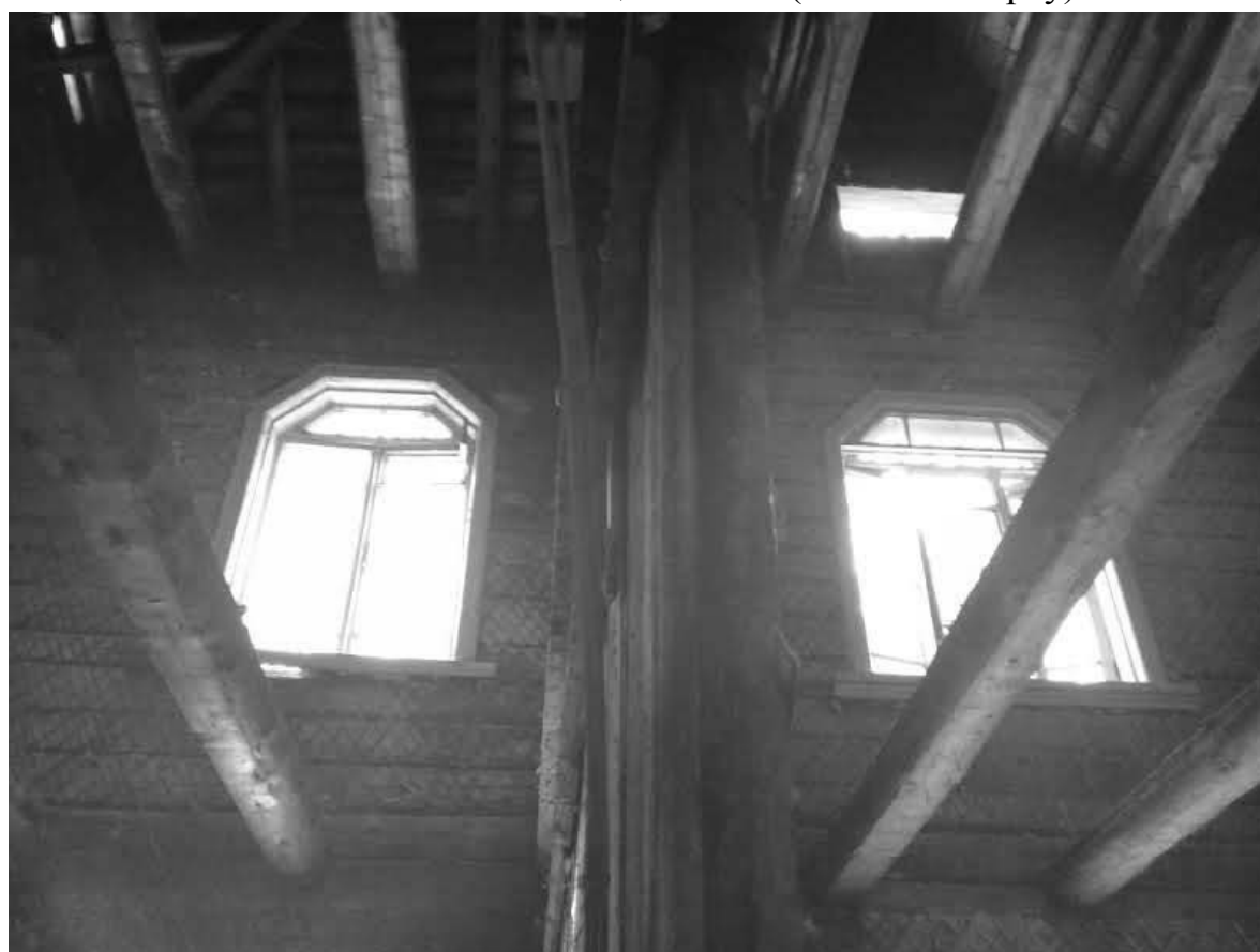
Фото № 22. Общий вид верхнего пространства над помещениями № 7 и 8 (по техпаспорту).
