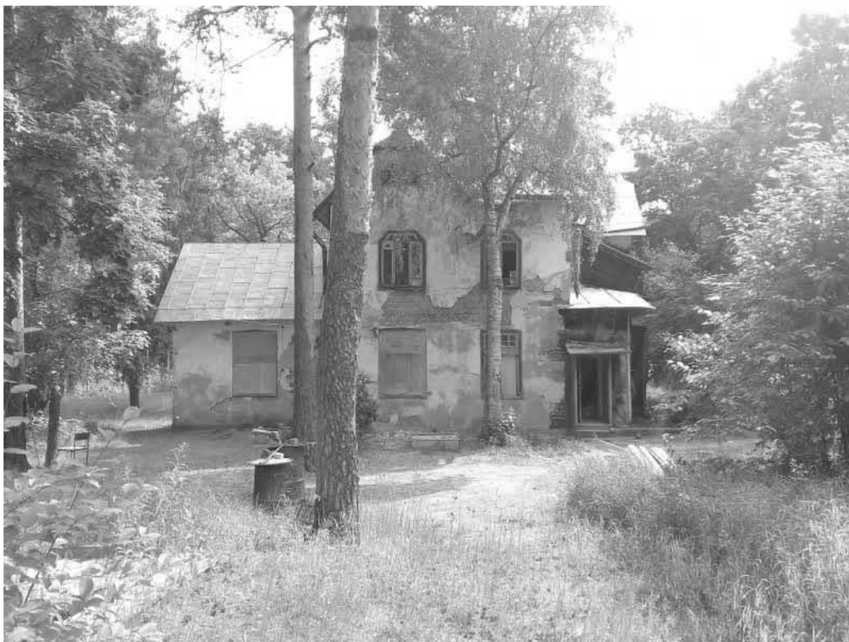
Фото № 9. Общий вид участка с запада.
