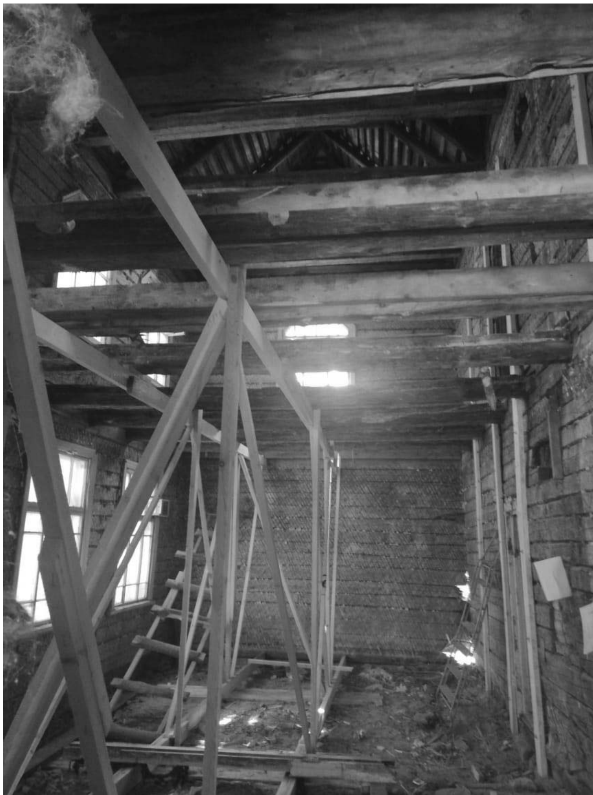
Фото № 16. Общий вид помещений № 3, 4 (по техпаспорту) с противоаварийными конструкциями.
