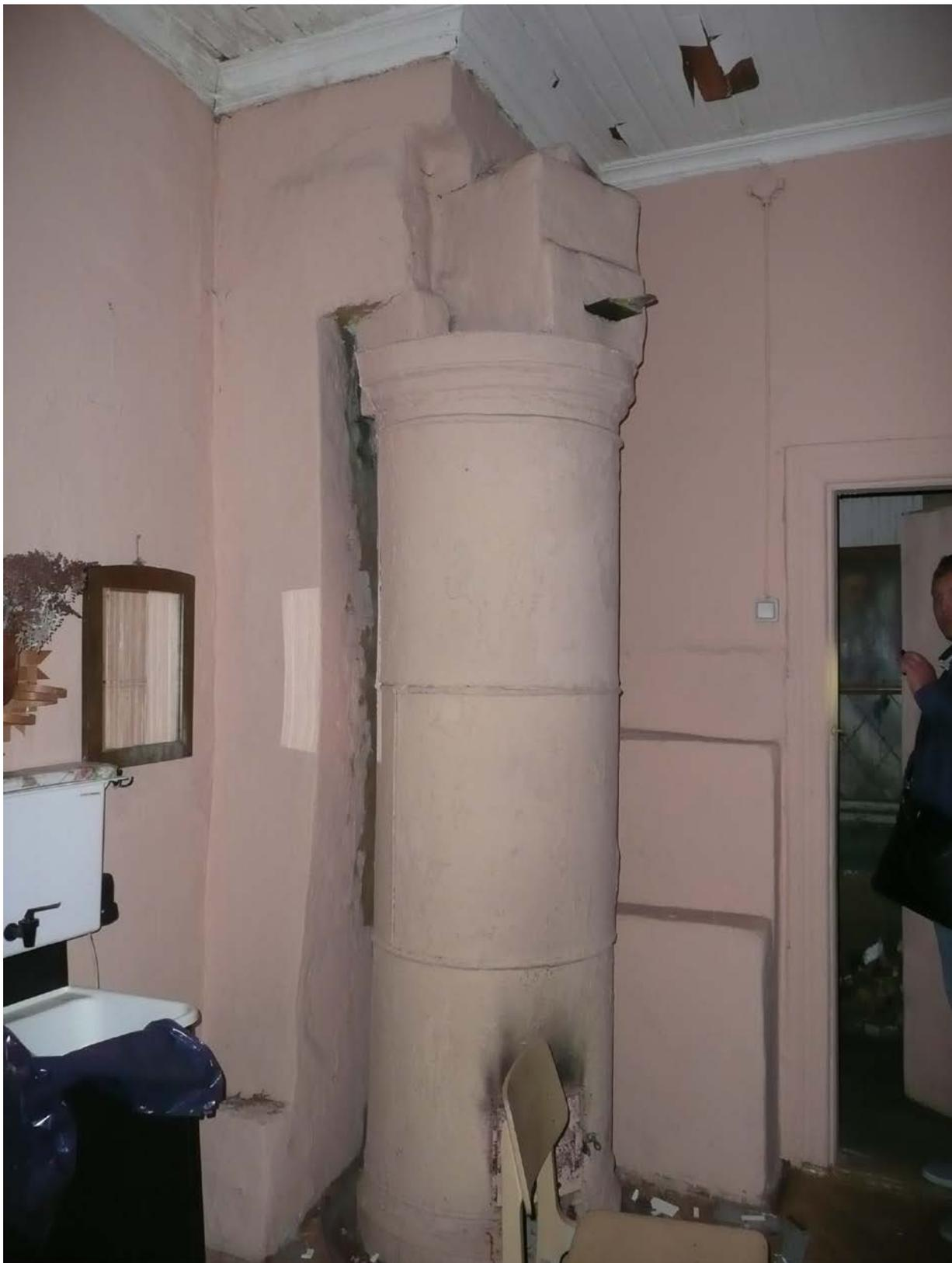
**Фото 58.** Железнодорожный вокзал станции Дибуны. Помещение 1-Н, комната № 3. Утермарковская печь (справа дверь, выходящая в тамбур (сени) дополнительного входа).
