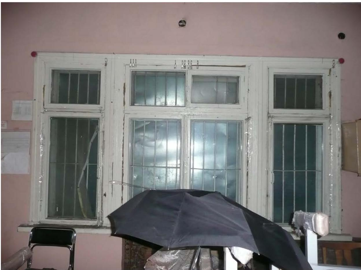
**Фото 54.** Железнодорожный вокзал станции Дибуны. Помещение 1-Н, фрагмент комнаты № 2. Оконное заполнение проема, выходящего на лицевой фасад здания.
