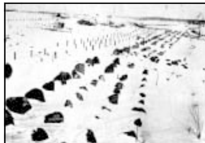
Линия противотанковых надолб перед долговременными сооружениями.
