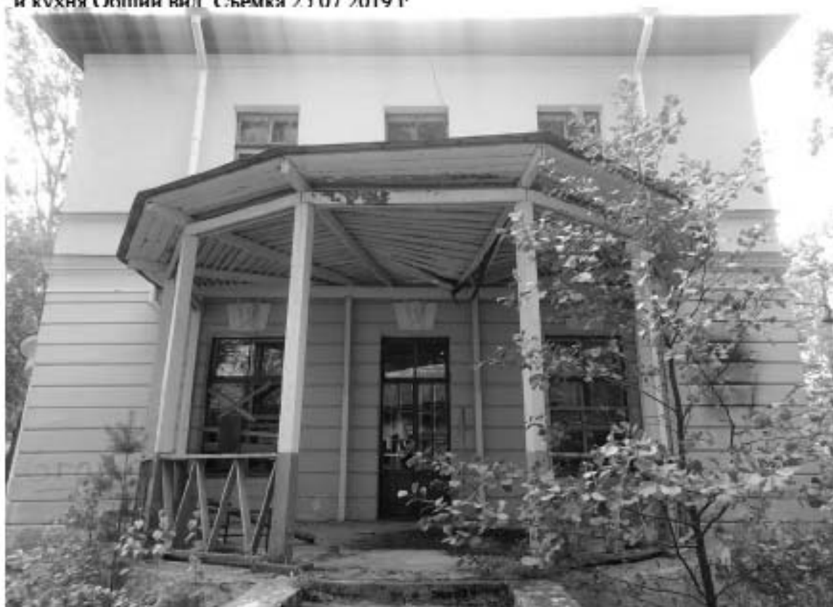
Фото 08. РЗ ОКН «Загородный дом Ф.Р. Витцеля». Северный фасад. Общий вид. Съёмка 25.07.2019 г.
