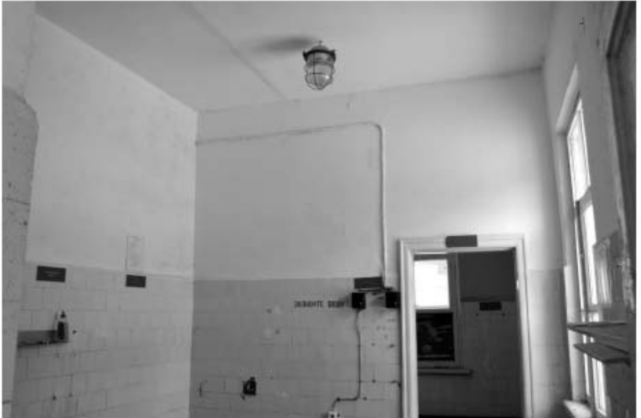
Фото 76. РЗ ОКН «Загородный дом Ф.Р. Витцеля». Кухня. Помещение № 6. Общий вид. Съёмка 25.07.2019 г.
