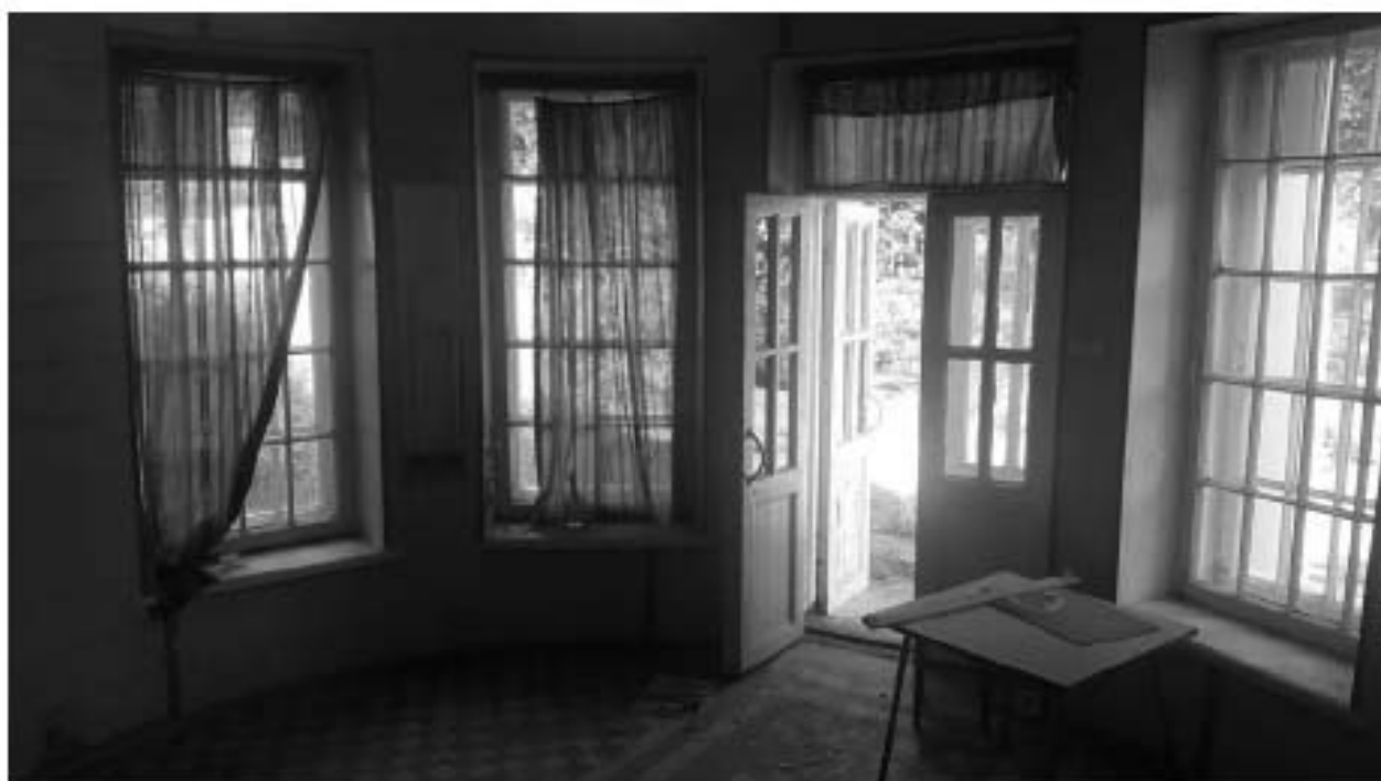
Фото 30. РЗ ОКН «Загородный дом Ф.Р. Витцеля». Вестибюль. Фрагмент. Съёмка 25.07.2019 г.
