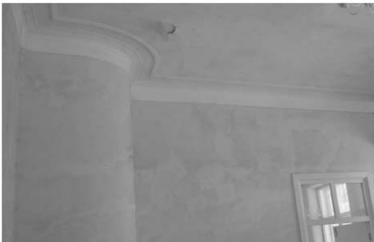
Фото 46. РЗ ОКН «Загородный дом Ф.Р. Витцеля». 1-ый этаж. Помещение № 3. Фрагмент. Съёмка 25.07.2019 г.
