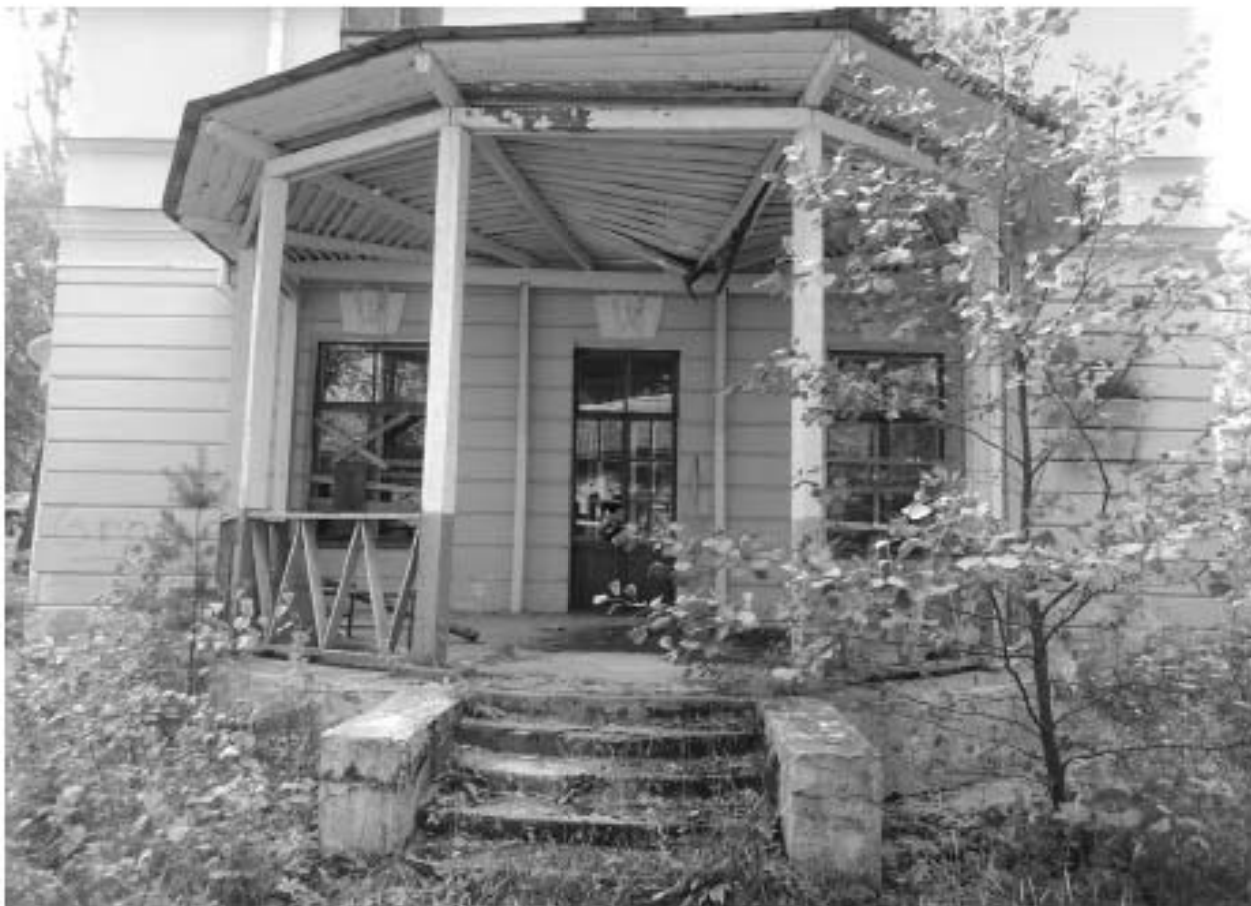
Фото 09. РЗ ОКН «Загородный дом Ф.Р. Витцеля». Северный фасад. Фрагмент. Полукруглая открытая веранда на каменном основании. Съёмка 25.07.2019 г.
