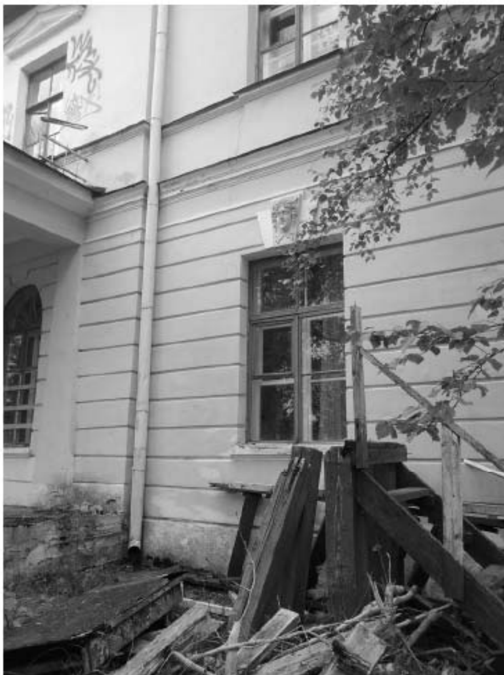
Фото 16. РЗ ОКН «Загородный дом Ф.Р. Витцеля». Западный фасад. Фрагмент. Оконный проём. Съёмка 25.07.2019 г.
