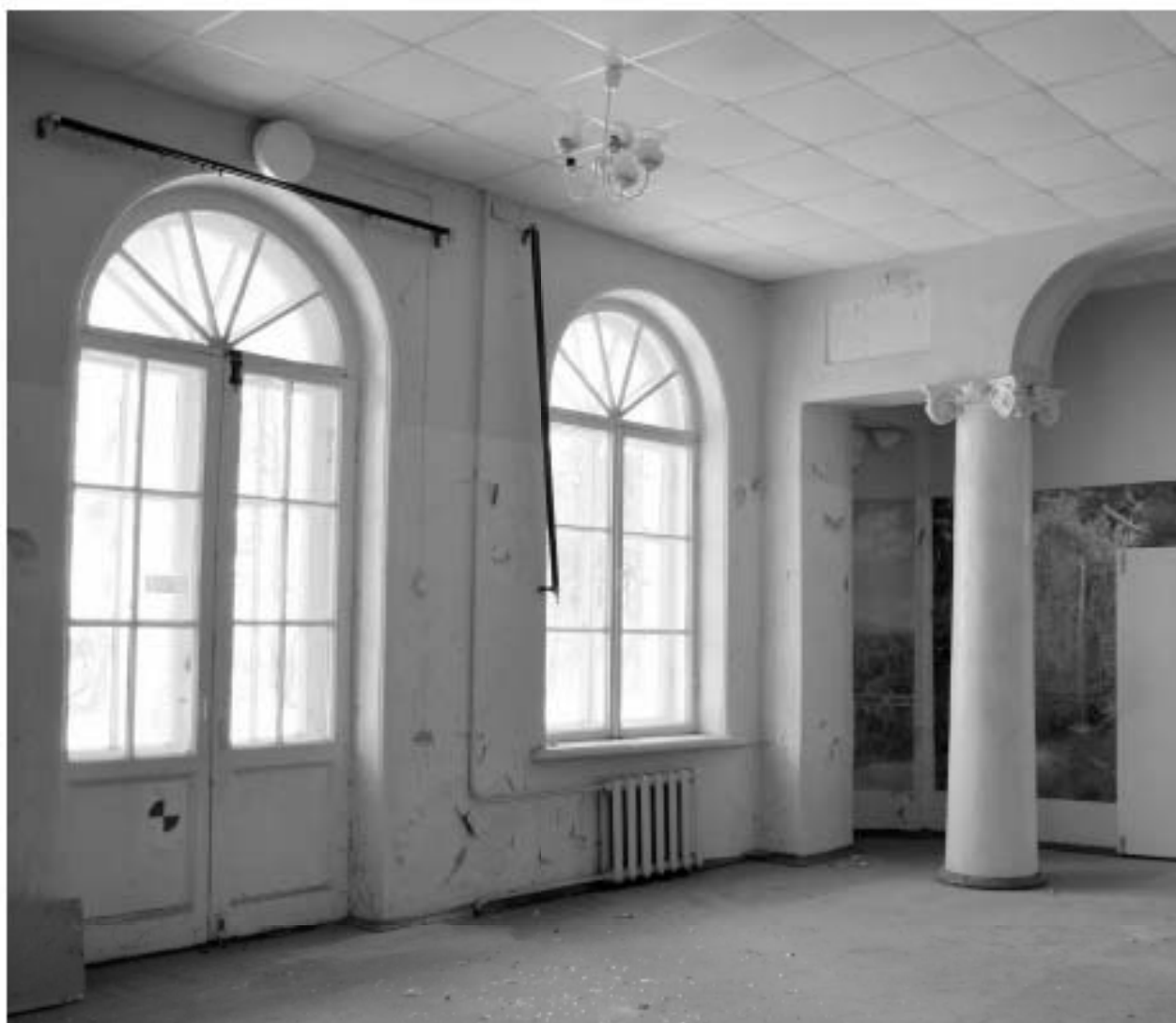
Фото 52. РЗ ОКН «Загородный дом Ф.Р. Витцеля». 1-ый этаж. Помещение № 5. Фрагмент. Съёмка 25.07.2019 г.
