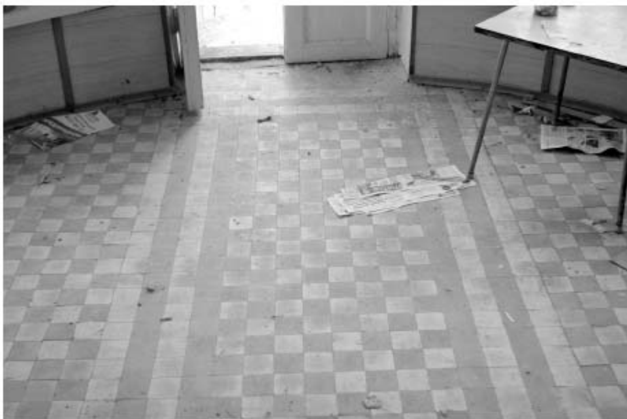
Фото 31. РЗ ОКН «Загородный дом Ф.Р. Витцеля». Вестибюль. Фрагмент. Покрытие пола. Съёмка 25.07.2019 г.
