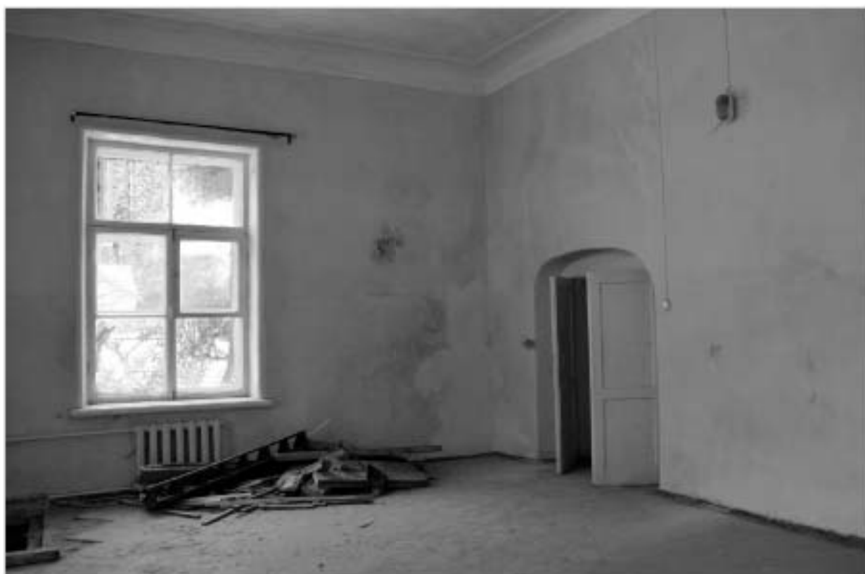
Фото 47. РЗ ОКН «Загородный дом Ф.Р. Витцеля». 1-ый этаж. Помещение № 3. Общий вид. Съёмка 25.07.2019 г.
