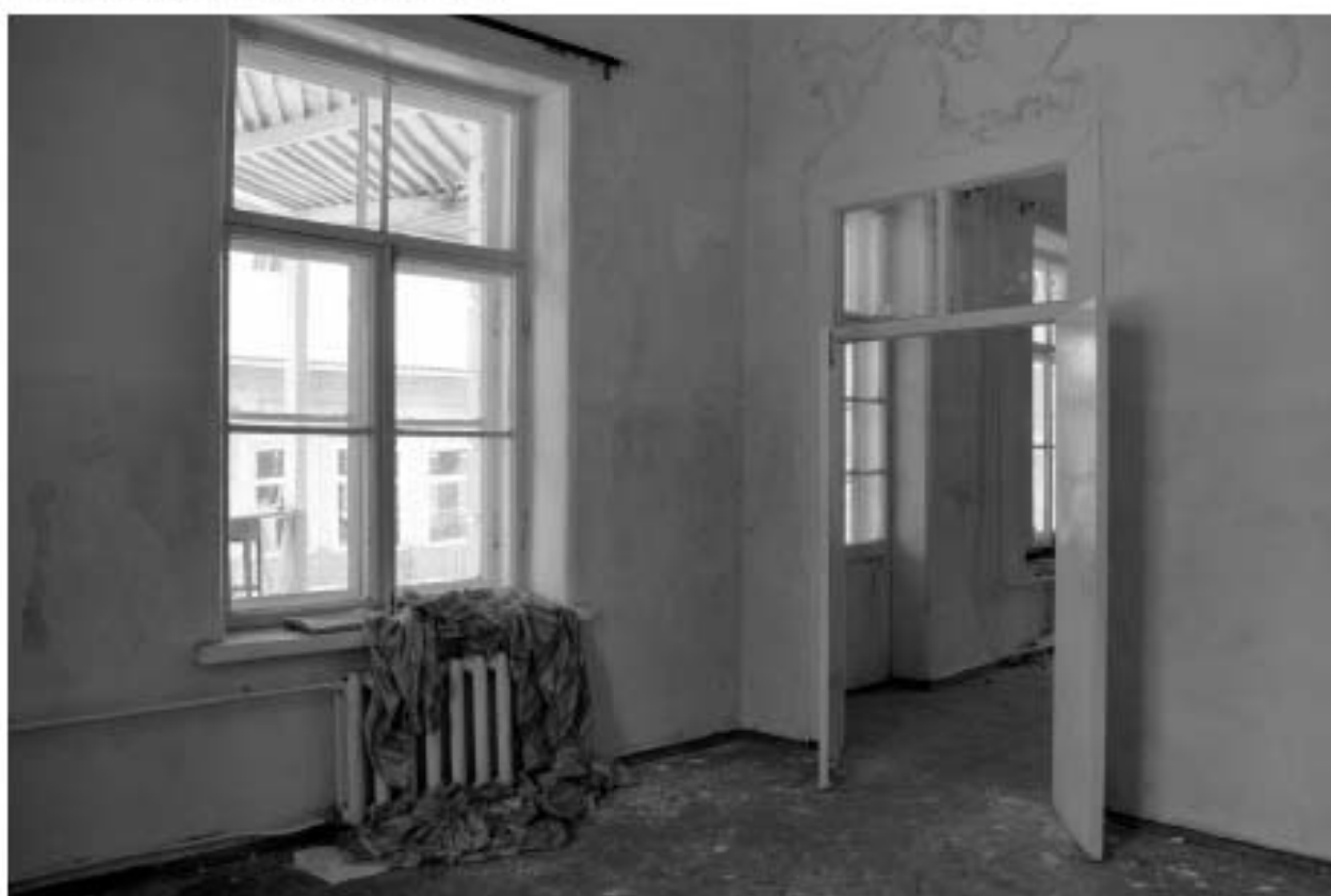
Фото 48. РЗ ОКН «Загородный дом Ф.Р. Витцеля». 1-ый этаж. Помещение № 4. Дверной проём, ведущий в помещение № 3. Съёмка 25.07.2019 г.
