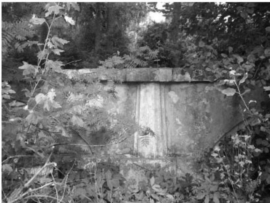
Фото 25. РЗ ОКН «Загородный дом Ф.Р. Витцеля». Историческая ограда. Фрагмент. Съёмка 25.07.2019 г.
