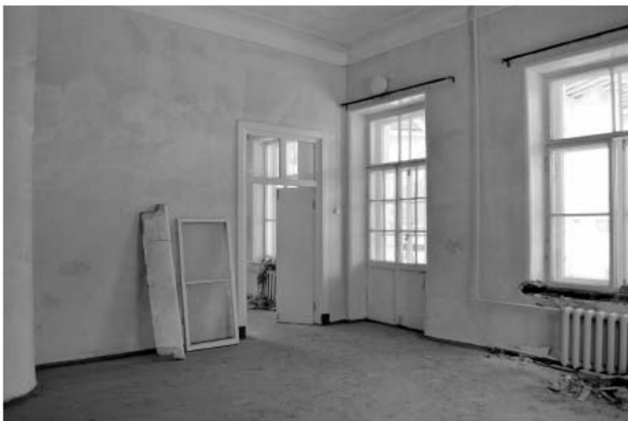
Фото 45. РЗ ОКН «Загородный дом Ф.Р. Витцеля». 1-ый этаж. Помещение № 3. Общий вид. Съёмка 25.07.2019 г.
