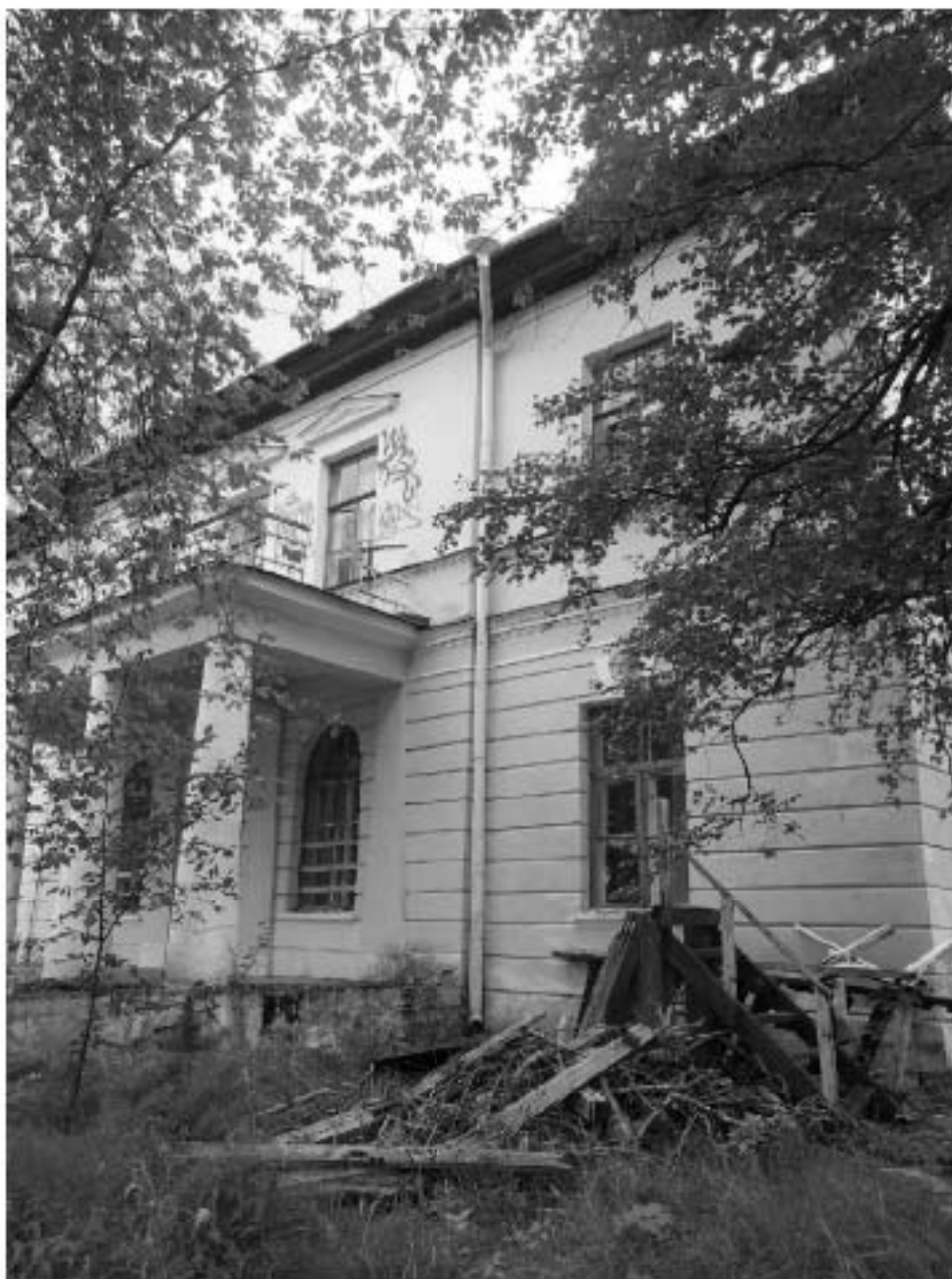
Фото 15. РЗ ОКН «Загородный дом Ф.Р. Витцеля». Западный фасад. Фрагмент. Поздняя лестница, ведущая на второй этаж. Съёмка 25.07.2019 г.
