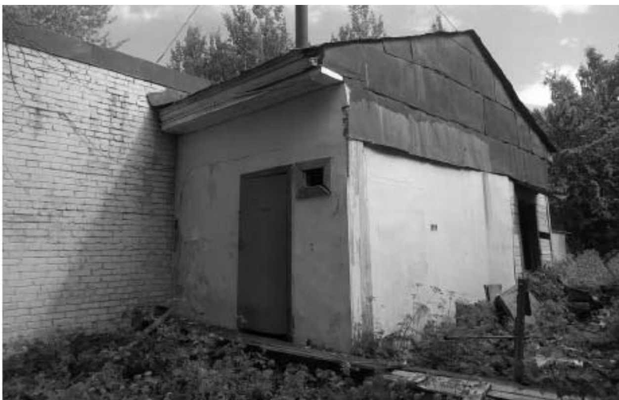
Фото 20. РЗ ОКН «Загородный дом Ф.Р. Витцеля». Поздняя пристройка, примыкающая к кухне. Съёмка 25.07.2019 г.
