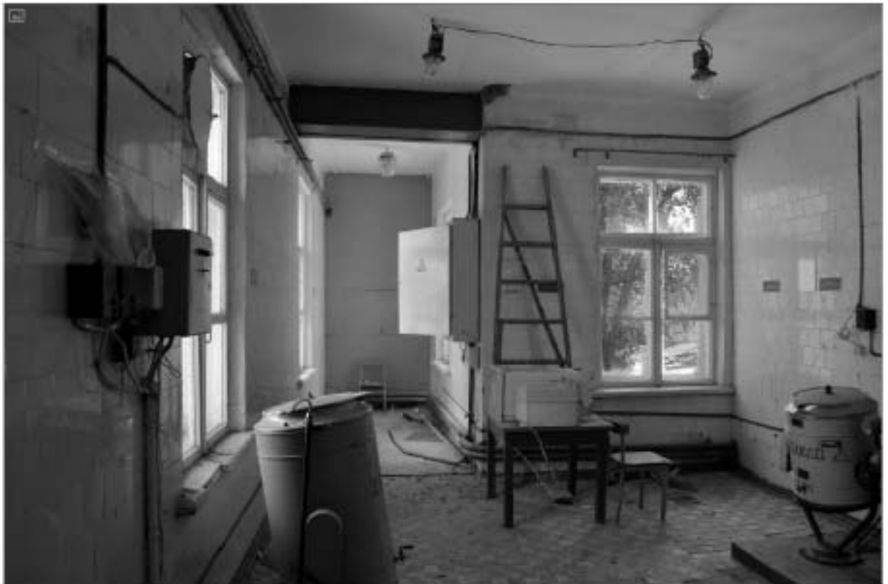
Фото 77. РЗ ОКН «Загородный дом Ф.Р. Витцеля». Кухня. Помещение № 5. Общий вид. Съёмка 25.07.2019 г.
