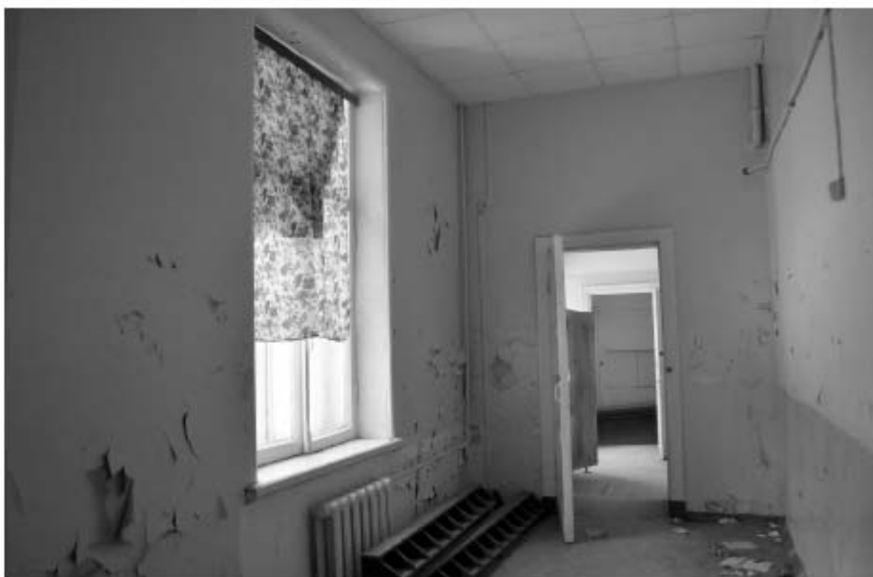
Фото 40. РЗ ОКН «Загородный дом Ф.Р. Витцеля». 1-ый этаж. Помещение № 9. Общий вид. Съёмка 25.07.2019 г.
