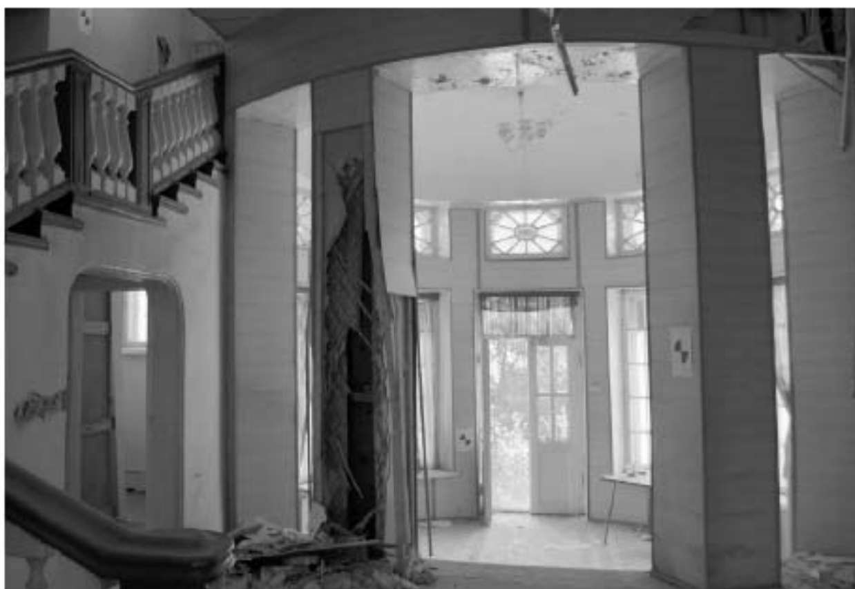
Фото 32. РЗ ОКН «Загородный дом Ф.Р. Витцеля». Вестибюль. Общий вид. Фрагмент парадной лестницы. Съёмка 25.07.2019 г.
