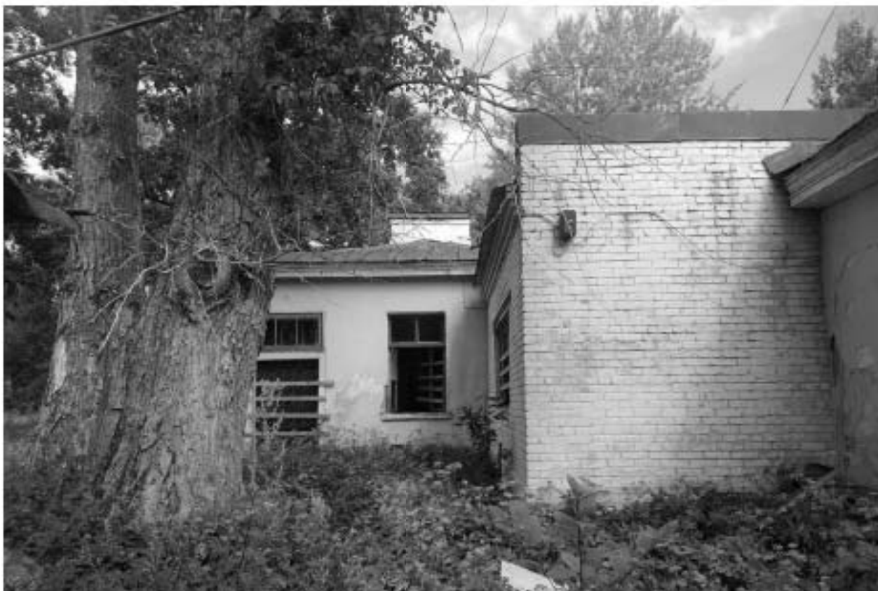
Фото 19. РЗ ОКН «Загородный дом Ф.Р. Витцеля». Здание кухни. Южный фасад. Примыкающая поздняя пристройка. Съёмка 25.07.2019 г.
