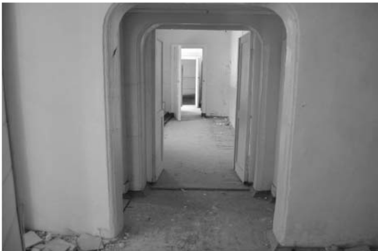
Фото 39. РЗ ОКН «Загородный дом Ф.Р. Витцеля». 1-ый этаж. Общий вид на помещения № 9, 10, 12. Съёмка 25.07.2019 г.
