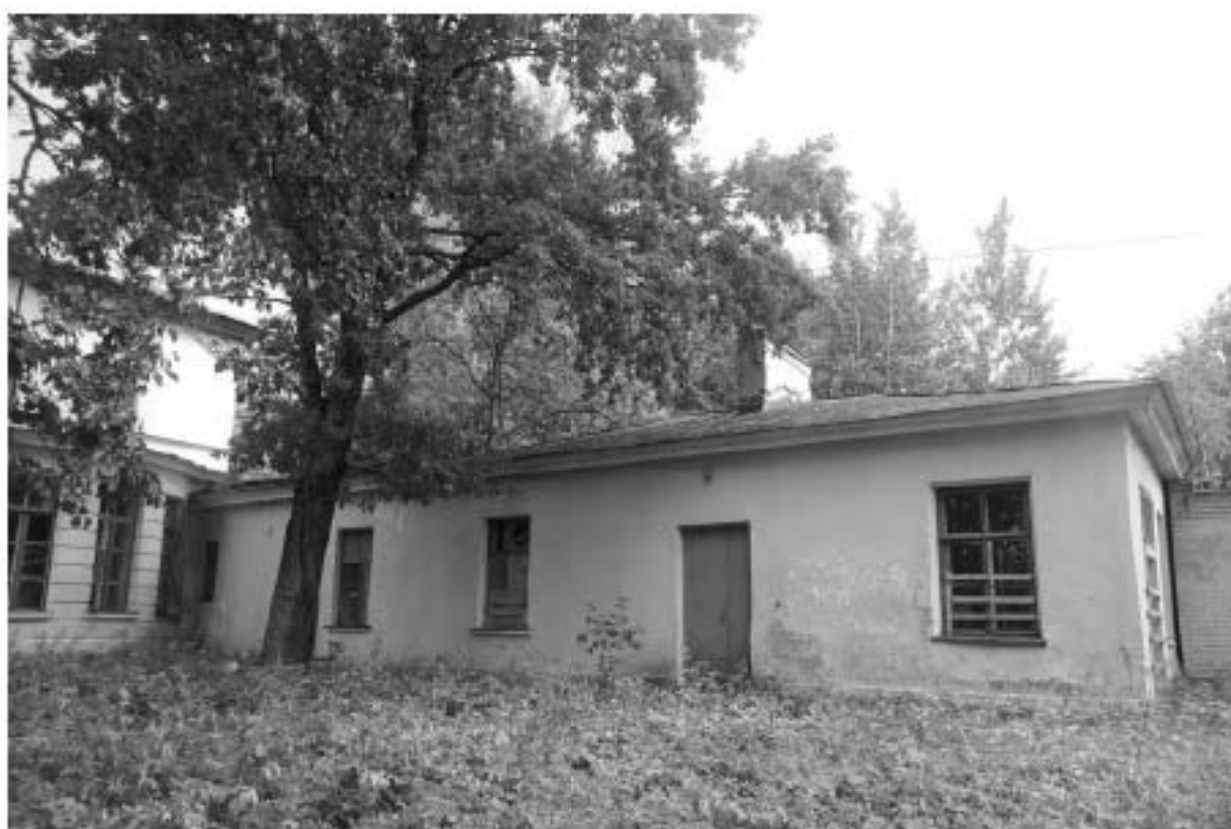
Фото 18. РЗ ОКН «Загородный дом Ф.Р. Витцеля». Галерея-переход и кухня. Западный фасад. Общий вид. Съёмка 25.07.2019 г.
