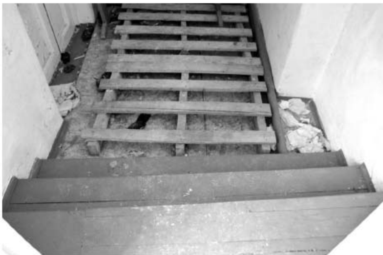
Фото 43. РЗ ОКН «Загородный дом Ф.Р. Витцеля». 1-ый этаж. Помещение № 12. Фрагмент. Съёмка 25.07.2019 г.
