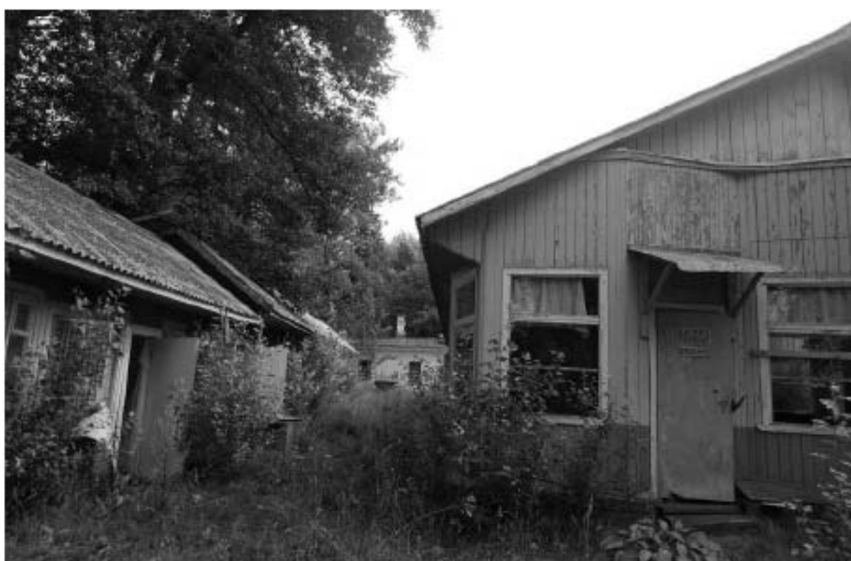
Фото 24. РЗ ОКН «Загородный дом Ф.Р. Витцеля». Постройки 1960-1970-х гг., расположенный в границах территории ОКН. Здания игротеки и спальный корпус. Съёмка 25.07.2019 г.
