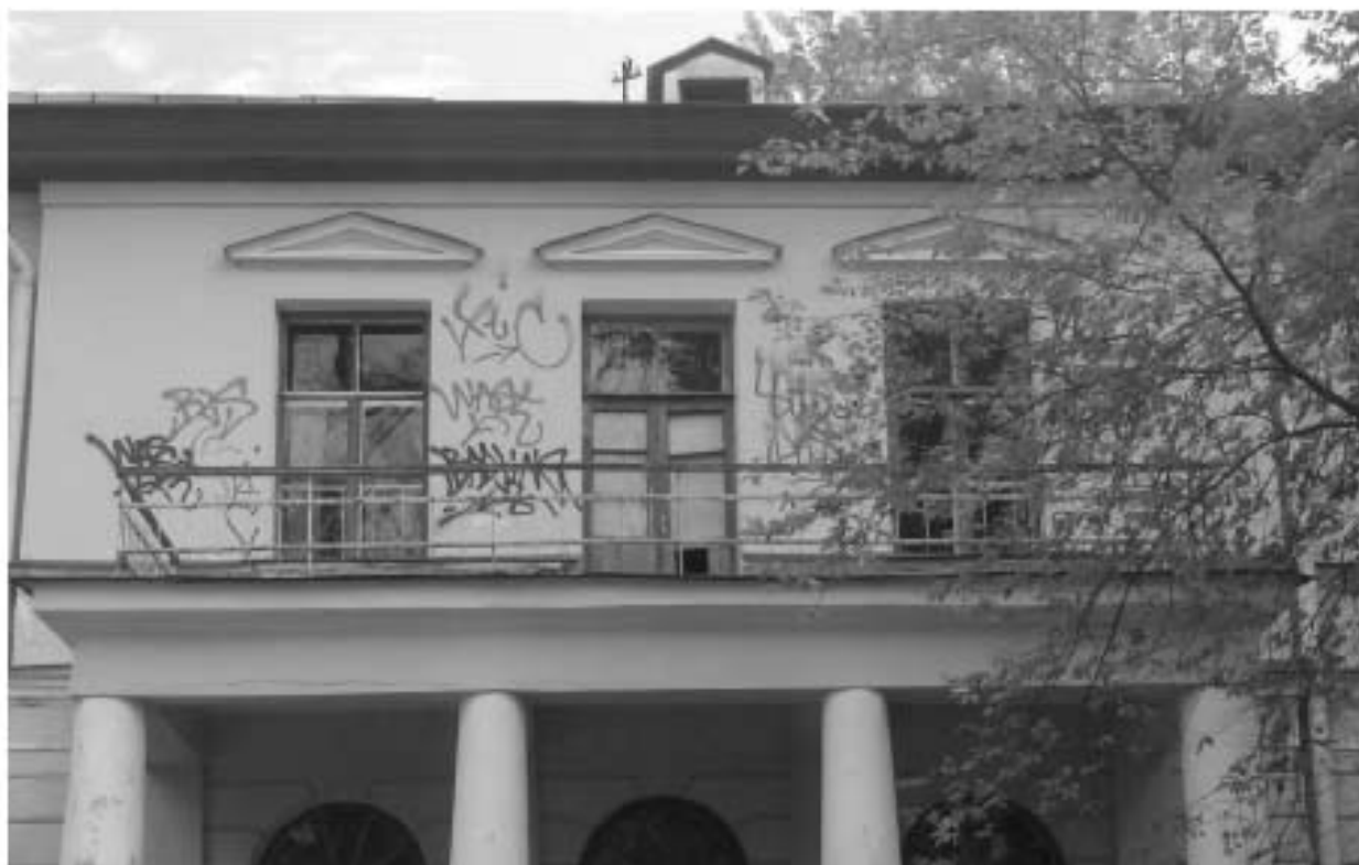
Фото 12. РЗ ОКН «Загородный дом Ф.Р. Витцеля». Западный фасад. Фрагмент. Оконные проёмы с сандриками. Съёмка 25.07.2019 г.
