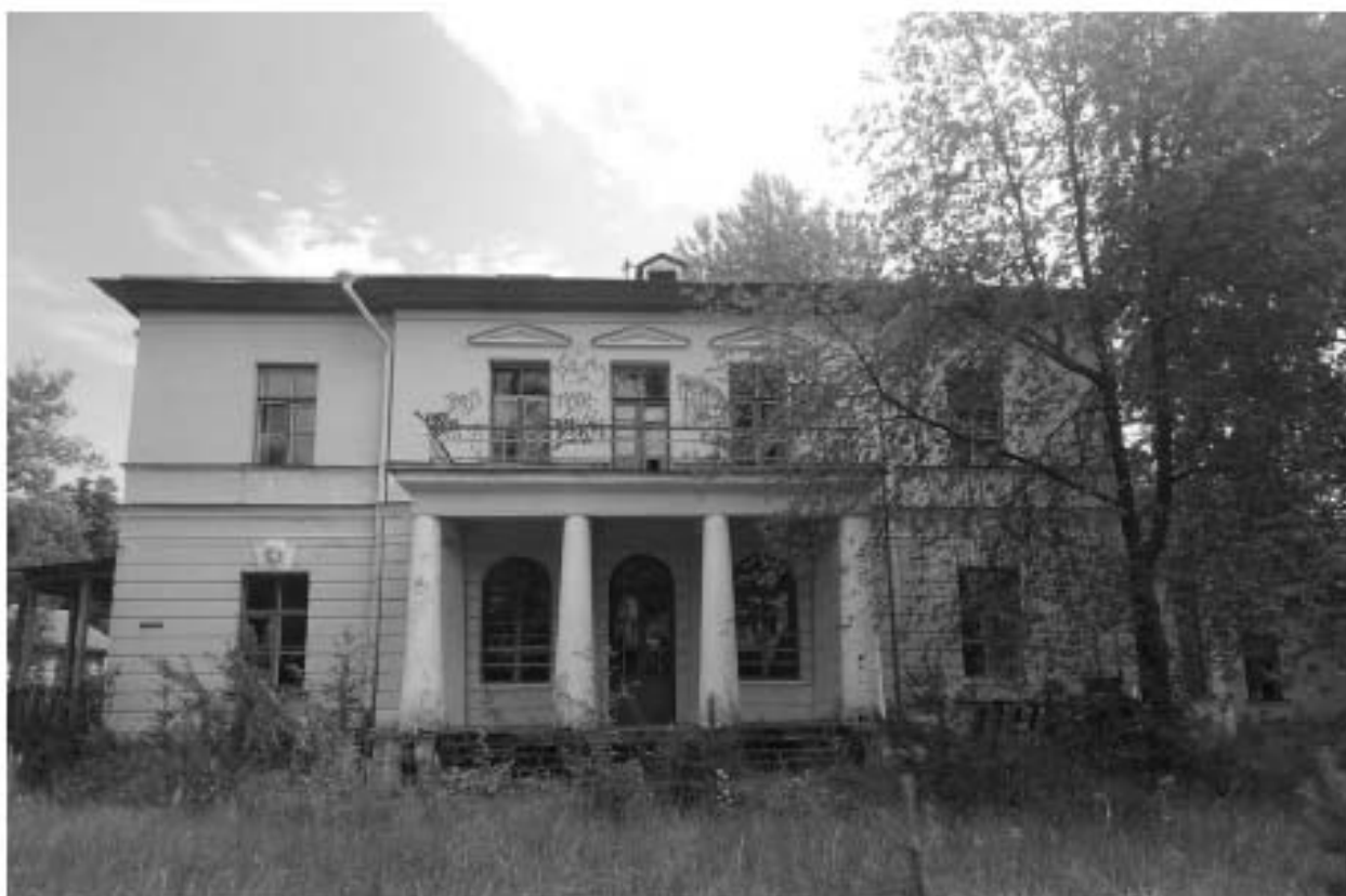
Фото 11. РЗ ОКН «Загородный дом Ф.Р. Витцеля». Западный фасад. Общий вид. Съёмка 25.07.2019 г.
