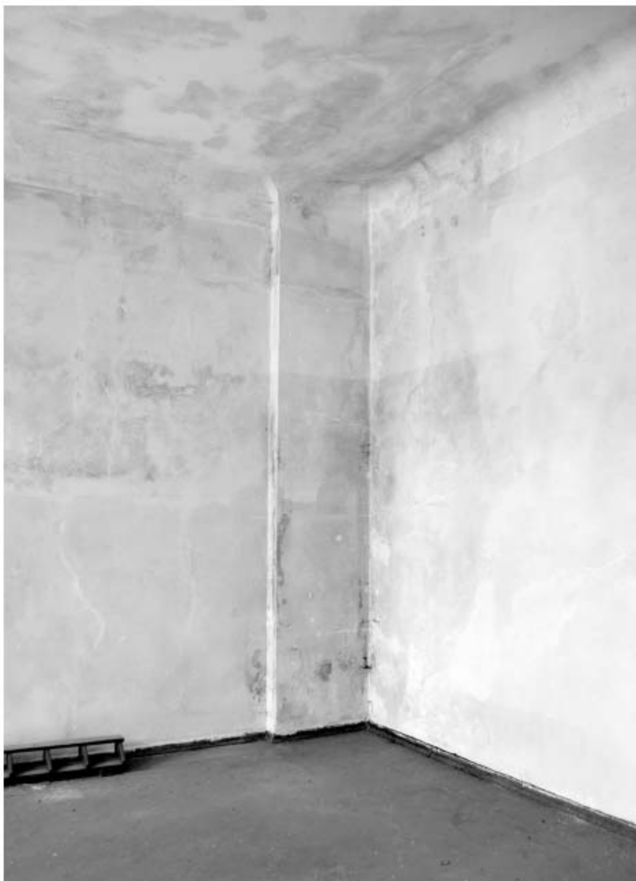
Фото 63. РЗ ОКН «Загородный дом Ф.Р. Витцеля». 2-ой этаж. Помещение № 21. Фрагмент. Съёмка 25.07.2019 г.
