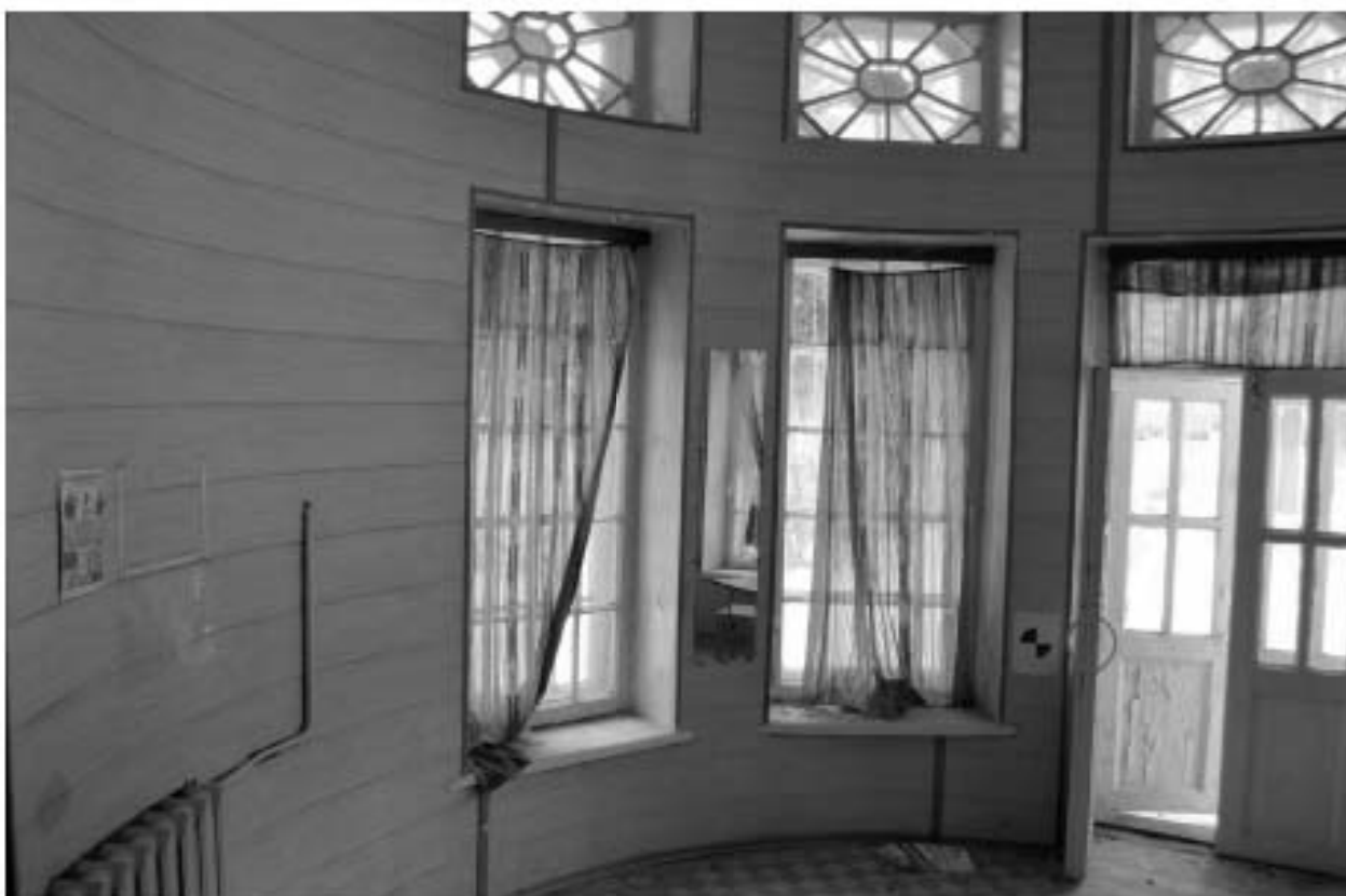
Фото 29. РЗ ОКН «Загородный дом Ф.Р. Витцеля». Вестибюль. Фрагмент. Съёмка 25.07.2019 г.
