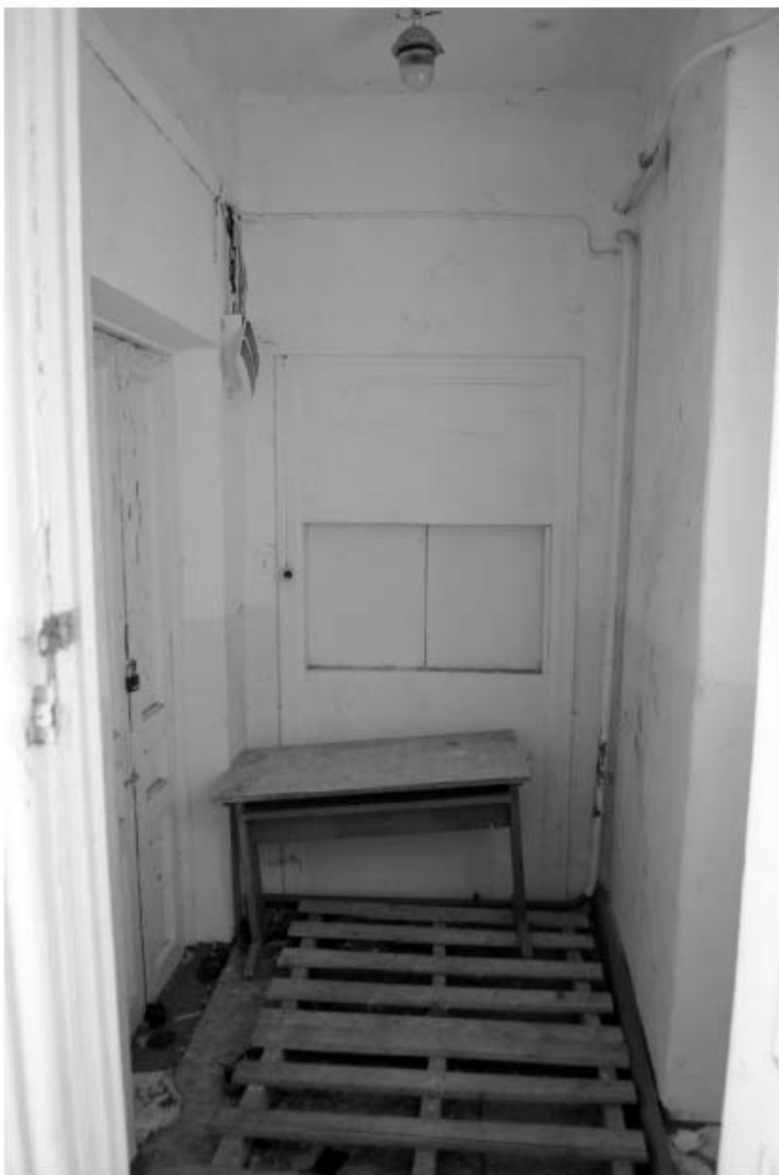
Фото 42. РЗ ОКН «Загородный дом Ф.Р. Витцеля». 1-ый этаж. Помещение № 12. Общий вид. Съёмка 25.07.2019 г.
