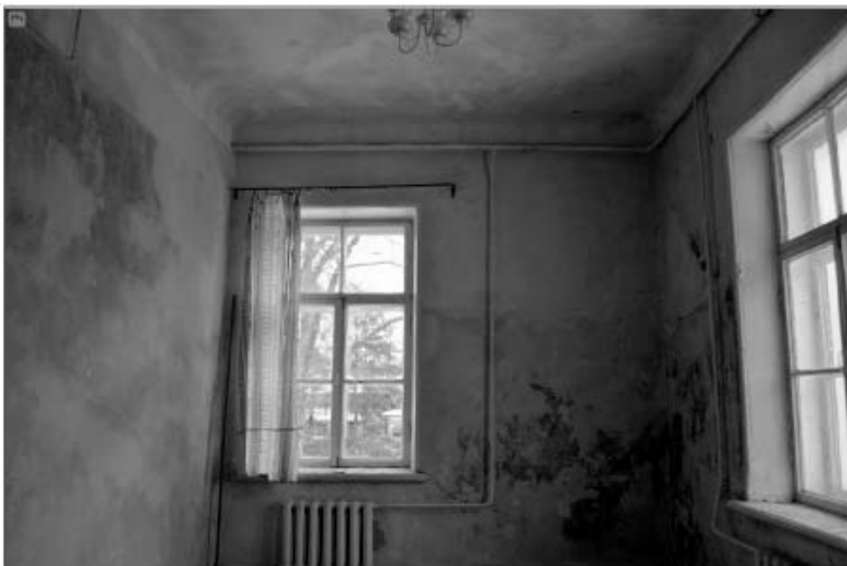
Фото 64. РЗ ОКН «Загородный дом Ф.Р. Витцеля». 2-ой этаж. Помещение № 20. Общий вид. Оконные проёмы. Съёмка 25.07.2019 г.
