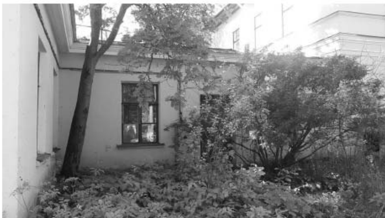
Фото 22. РЗ ОКН «Загородный дом Ф.Р. Витцеля». Восточный фасад. Галерея - переход. Общий вид. Съёмка 25.07.2019 г.
