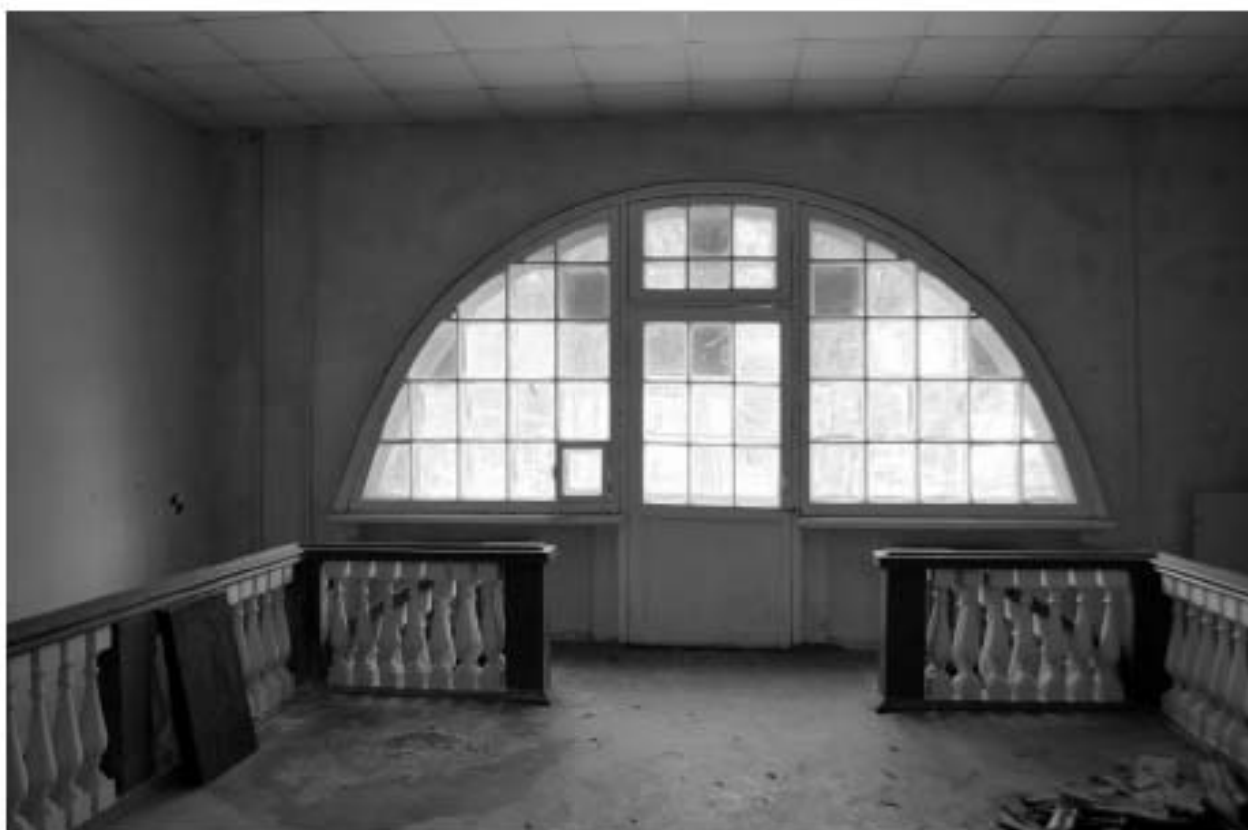
Фото 37. РЗ ОКН «Загородный дом Ф.Р. Витцеля». Парадная лестница. Площадка 2-го этажа. Общий вид. Съёмка 25.07.2019 г.
