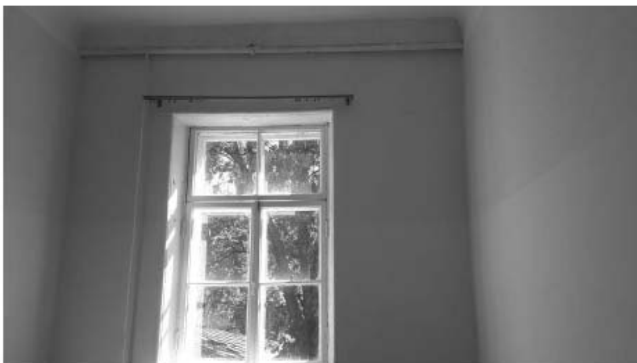
Фото 60. РЗ ОКН «Загородный дом Ф.Р. Витцеля». 1-ый этаж. Помещение № 6. Фрагмент. Подоконная доска. Съёмка 25.07.2019 г.
