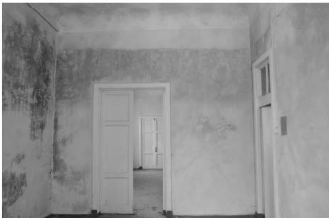
Фото 65. РЗ ОКН «Загородный дом Ф.Р. Витцеля». 2-ой этаж. Помещение № 20. Общий вид. Дверные проёмы. Съёмка 25.07.2019 г.
