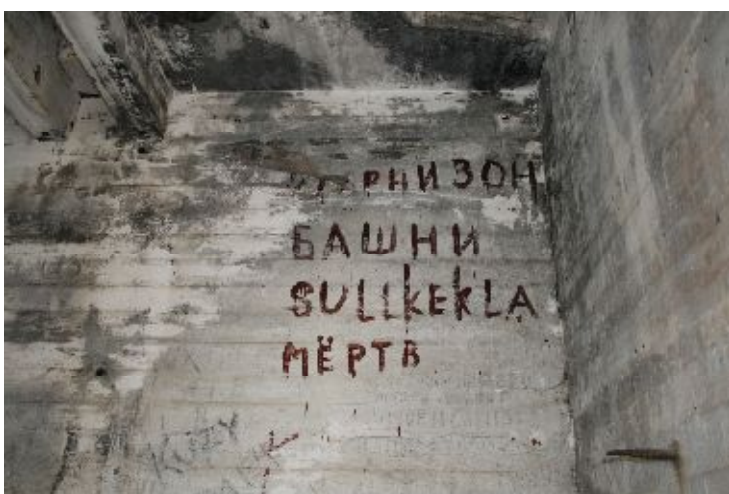
Вид надписи на стене 1 этажа. Гарнизон башни «sullkekla» мертв. 1939 г
